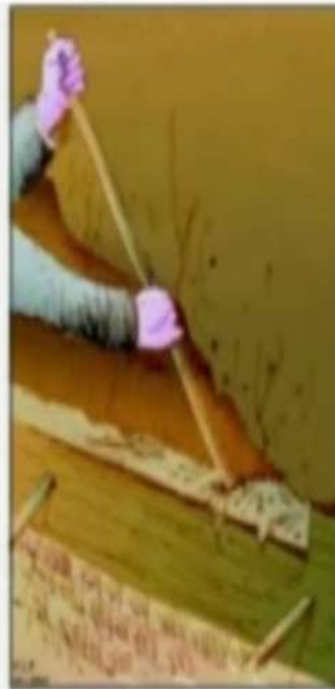
Metodo per la ricostruzione della muratura degradata in bauge o pisé.
