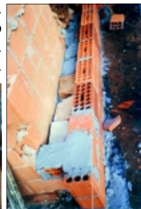
Fase terza: costipamento della intercapedine.
