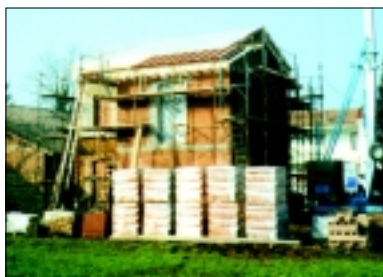
Costruzione del tetto in latero-cemento.
