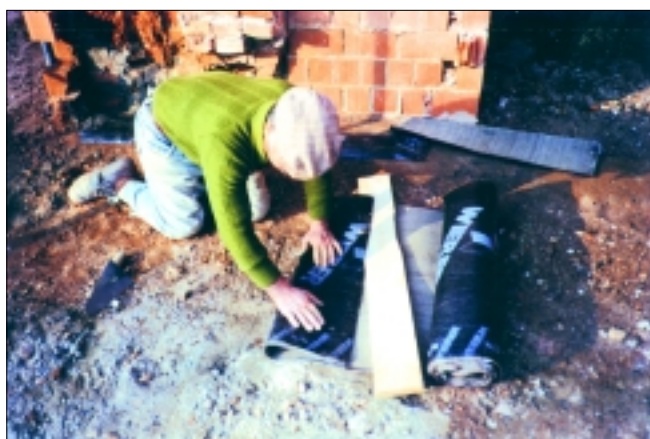
Terza fase: taglio su misura di una guaina impermeabilizzante e successiva posa in opera.
