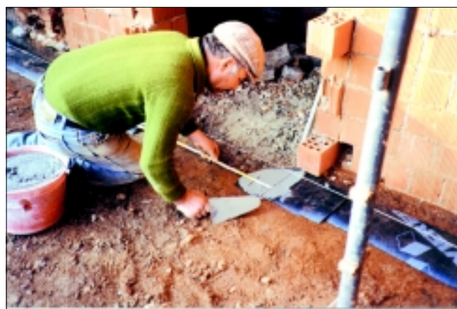
Terza fase: taglio su misura di una guaina impermeabilizzante e successiva posa in opera.
