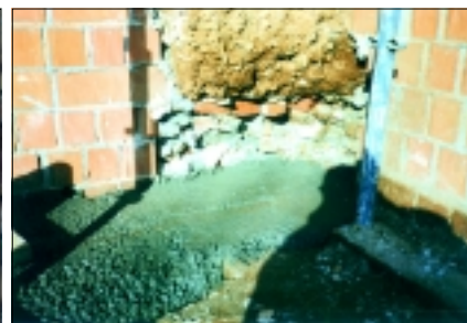
Seconda fase: getto di calcestruzzo, se necessario debolmente armato. Si compie la stessa operazione sui tratti di fondazione non ancora rimossi.
