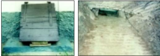
*Grotta scavata interamente nel terreno vergine (a destra). Bocca di lupo coperta esternamente da una protezione rimovibile in legno (sopra).*
