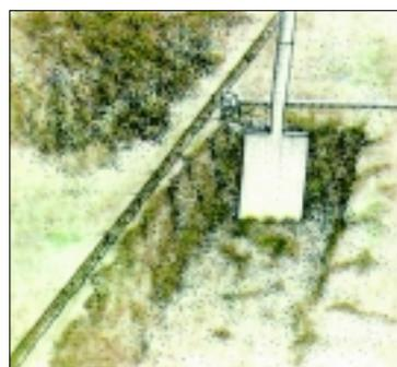
Per prima cosa si operava sul terreno il tracciamento del perimetro del fabbricato, piantando dei pali in modo da delimitare gli angoli; ai pali si legava poi il filo della lignola che delimitava lo scavo delle fondazioni.
