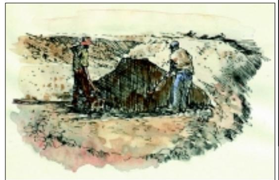
In primavera, una volta testata la **lavorabilità del terreno**, strizzandola nel pugno della mano per valutarne la plasticità (*tachègna*), si dava inizio al cantiere, partendo dal tracciamento del fosso di **fondazione**.
