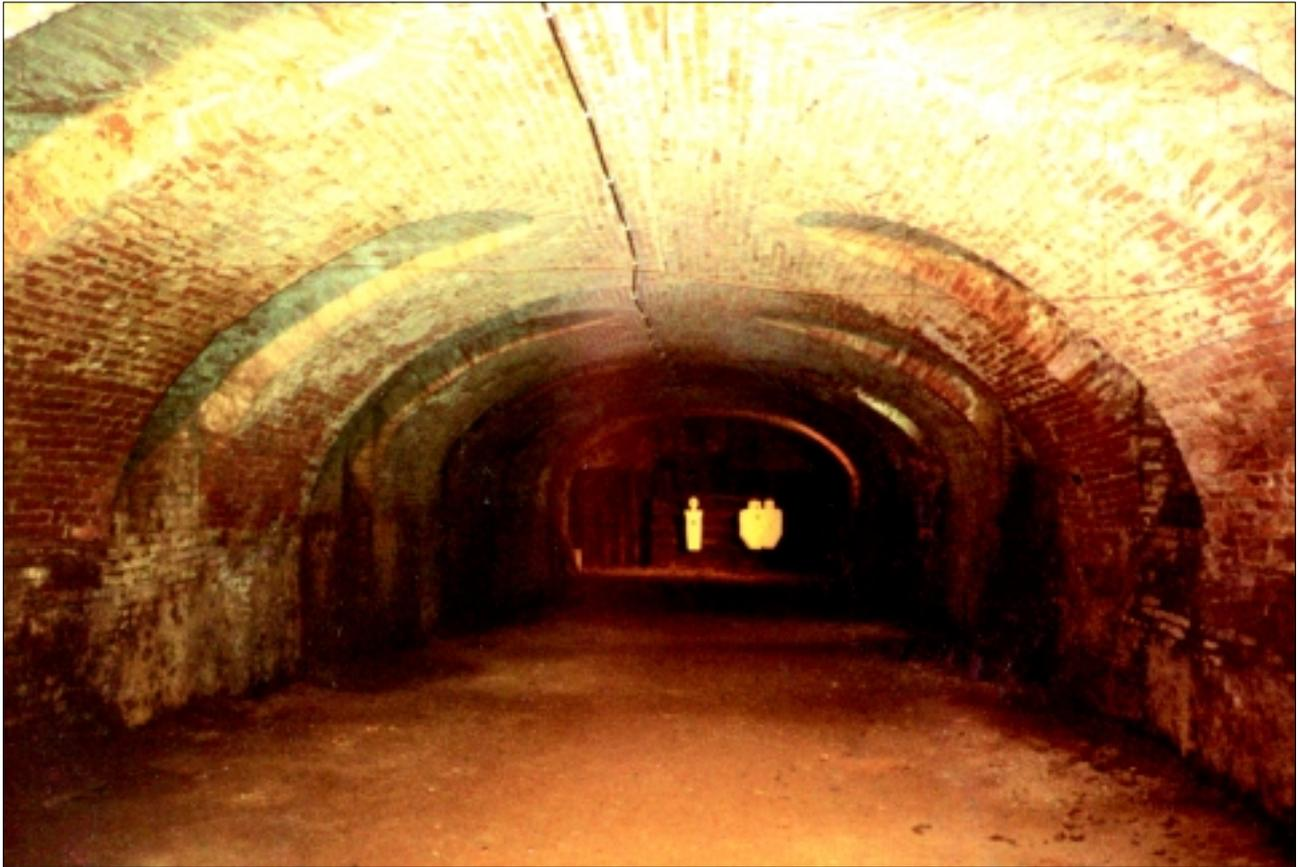
*L'ampia mole dello scantinato della Ca' Bianca (Mandrogne), conservato in ottimo stato, con un'ampia volta a botte munita di ampie unghie e impostata su un basamento in mattoni cotti.*
