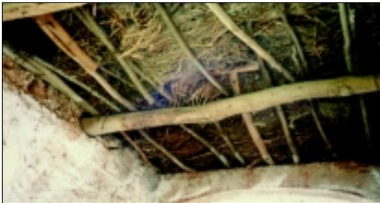
Esempio di un ipotetico soffitto non praticabile (a), ottenuto con materiale di scarto (foto a destra), atto a separare il piccolo locale sospeso, ritagliato nel vano scala (foto nel riquadro) con i locali del sottotetto. Questo minuscolo spazio, con accesso dalla camera da letto, ha un voltino in laterizi che funge da piano di calpestio (b) e si chiude con una muratura inclinata in mattoni (c). Questo ambiente è molto usuale in Fraschetta ed ha solitamente due funzioni: ripostiglio o bagno.
