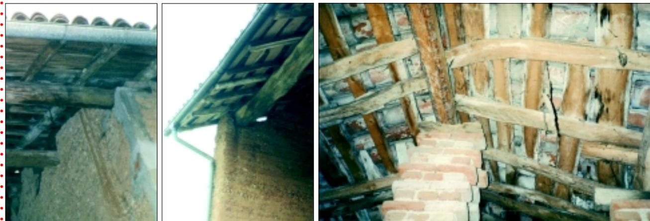
*Particolare della zona d'appoggio delle terzere: a-b) direttamente sulla muratura in terra; c) su pilastrini in mattoni cotti.*
