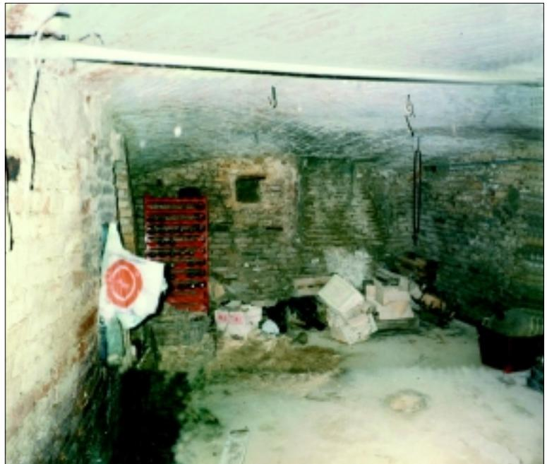
*Cantina provvista di pavimento in battuto di calcestruzzo, con pareti rivestite di laterizi cotti e volta a vela molto ribassata, con armatura dei conci a spina di pesce.*
