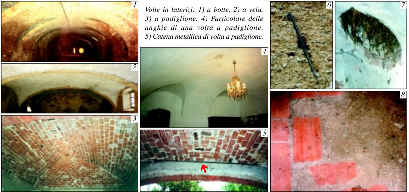
Volte in laterizi: 1) a botte, 2) a vela, 3) a padiglione. 4) Particolare delle unghie di una volta a padiglione. 5) Catena metallica di volta a padiglione.
