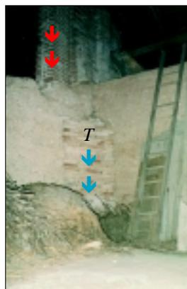
Ultimi particolari citati sono la precaria *piattabanda di scarico* in laterizi che devia i carichi provenienti dal tetto compreso il peso proprio del pilastro in mattoni e il *voltino di scarico* della muratura di tamponamento che evita il contatto con la volta trasferendo direttamente alla muratura tutto il peso.
