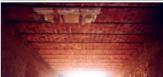
Soffitto a voltini di laterizio, con travi in legno e con putrelle in ferro.
