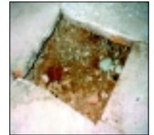
Le piastrelle laterizie venivano posizionate direttamente sul terreno, senza porsi il problema di un adeguato sottofondo che riducesse l'umidità di risalita.
