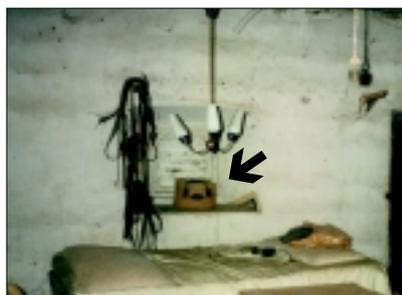
Le *finestre tamponate*, perchè rese inutilizzabili a seguito della sopraelevazione del tetto, rimangono ancora ben visibili sia dal sottotetto che dall’interno delle camere. Il motivo? Evidentemente questi rattoppi non pesavano esteticamente sui poveri inquilini che dimoravano un tempo in queste camere.
