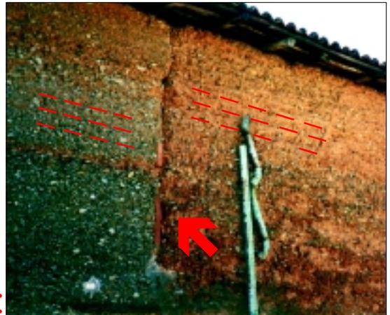
Stratificazione di una muratura. È possibile notare la frattura tra due murature adiacenti, colmata con laterizi.
