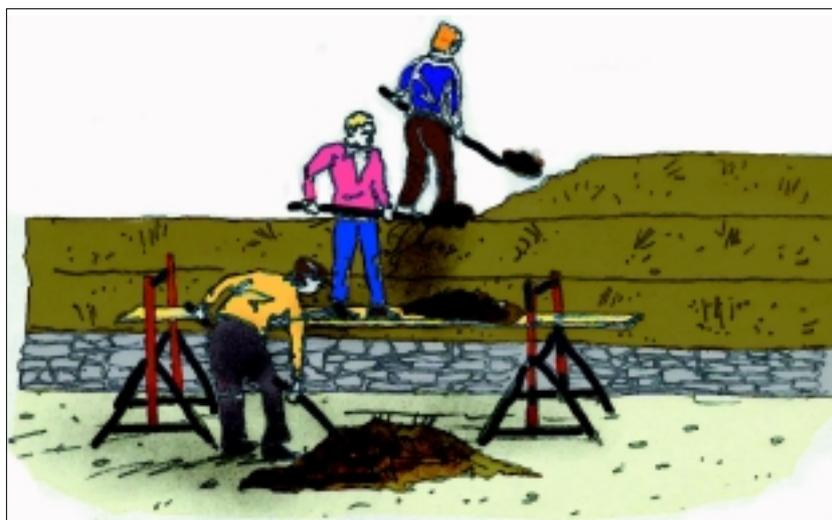
*Muratura realizzata con la tecnica del bauge.*
