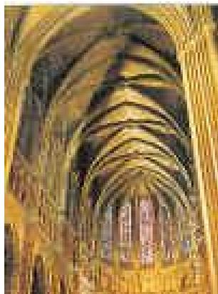
Il peso stesso degli archi rampanti crea la spinta laterale; il peso stesso delle pietre della volta crea la spinta verticale, dal basso in alto, dalla chiave di volta.
