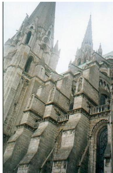
riscontra alcuna traccia anteriore, nel quale la volta - sostenuta da due archi rampanti - si fenderebbe sotto la loro spinta se non fosse stabilizzata dalla chiave di volta.
