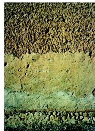
*Fig. 2a - Tessitura muraria del muro in pisé dell'area centrale della Frascchéta (si nota la classica fondazione in ciottoli e mattoni cotti sulla quale è impostata la muratura monolitica in pisé, intonacata solamente nelle parti destinate all'abitazione).*
